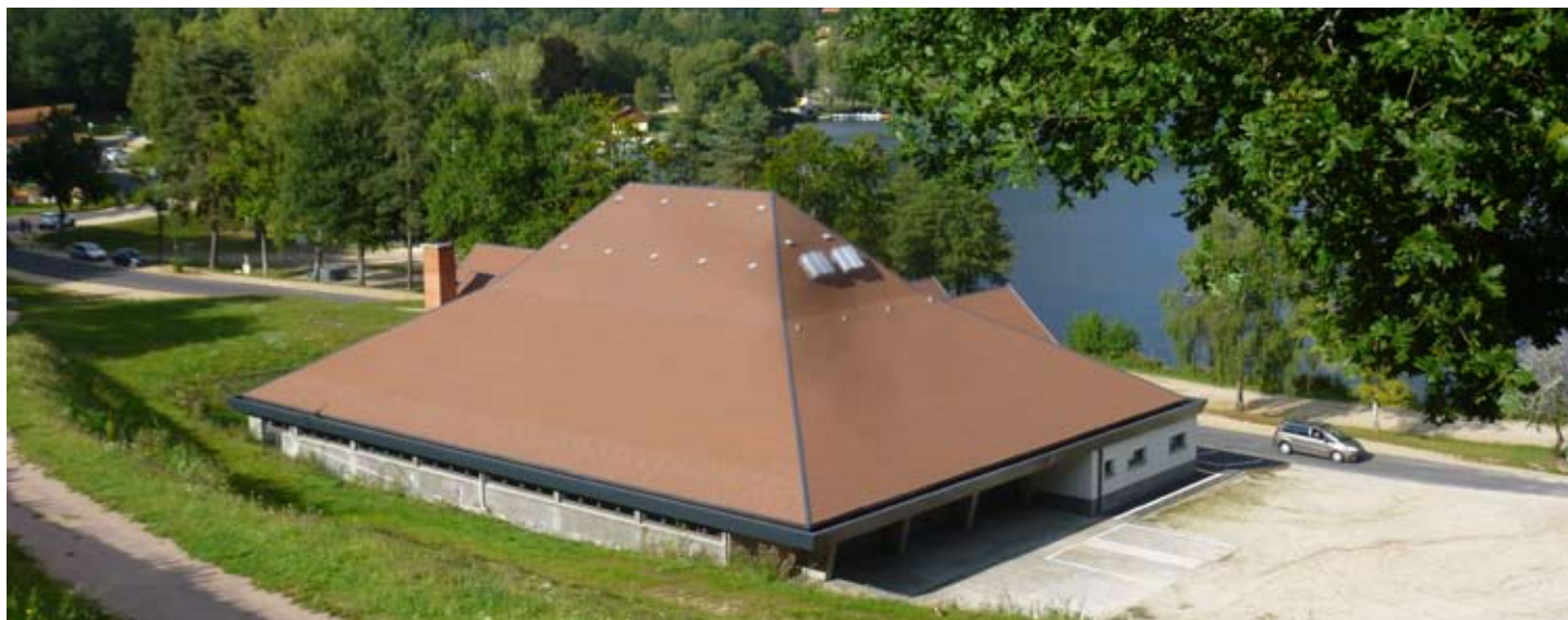
► Nouvelle couverture de la salle des fêtes
