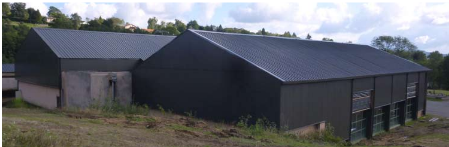
● Toits des tennis en attente de la pose des panneaux photovoltaïques
